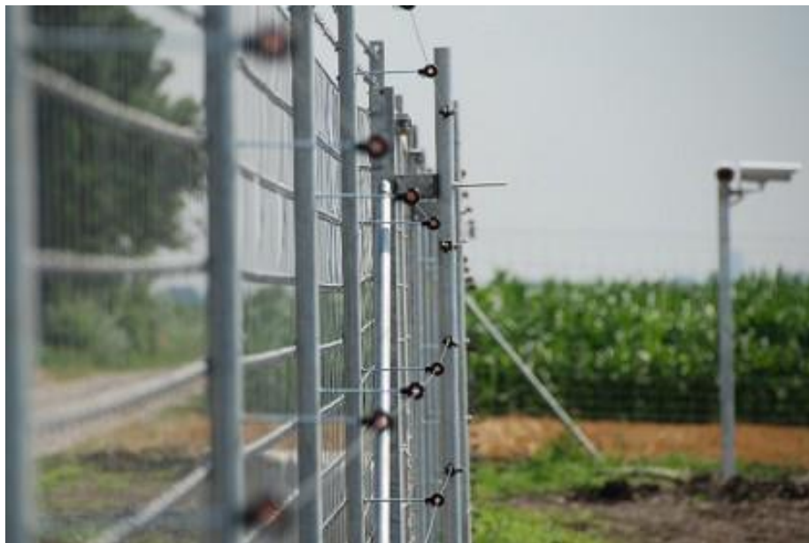
Rysunek 3. Przykładowe ogrodzenie farmy fotowoltaicznej.
