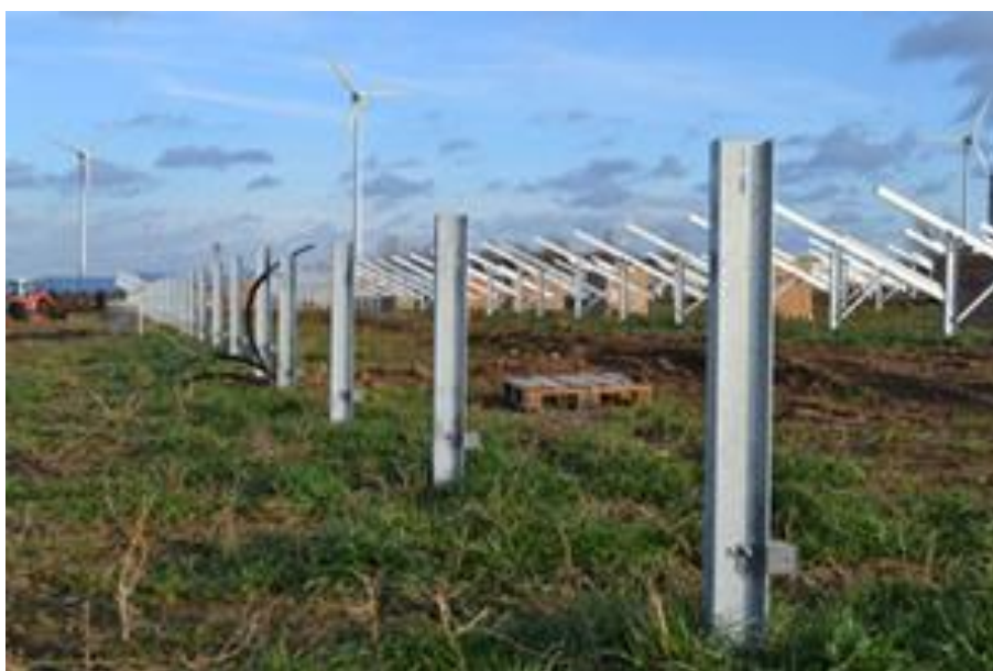
Zdjęcie 1. Profile metalowe: podstawowy element konstrukcji.
